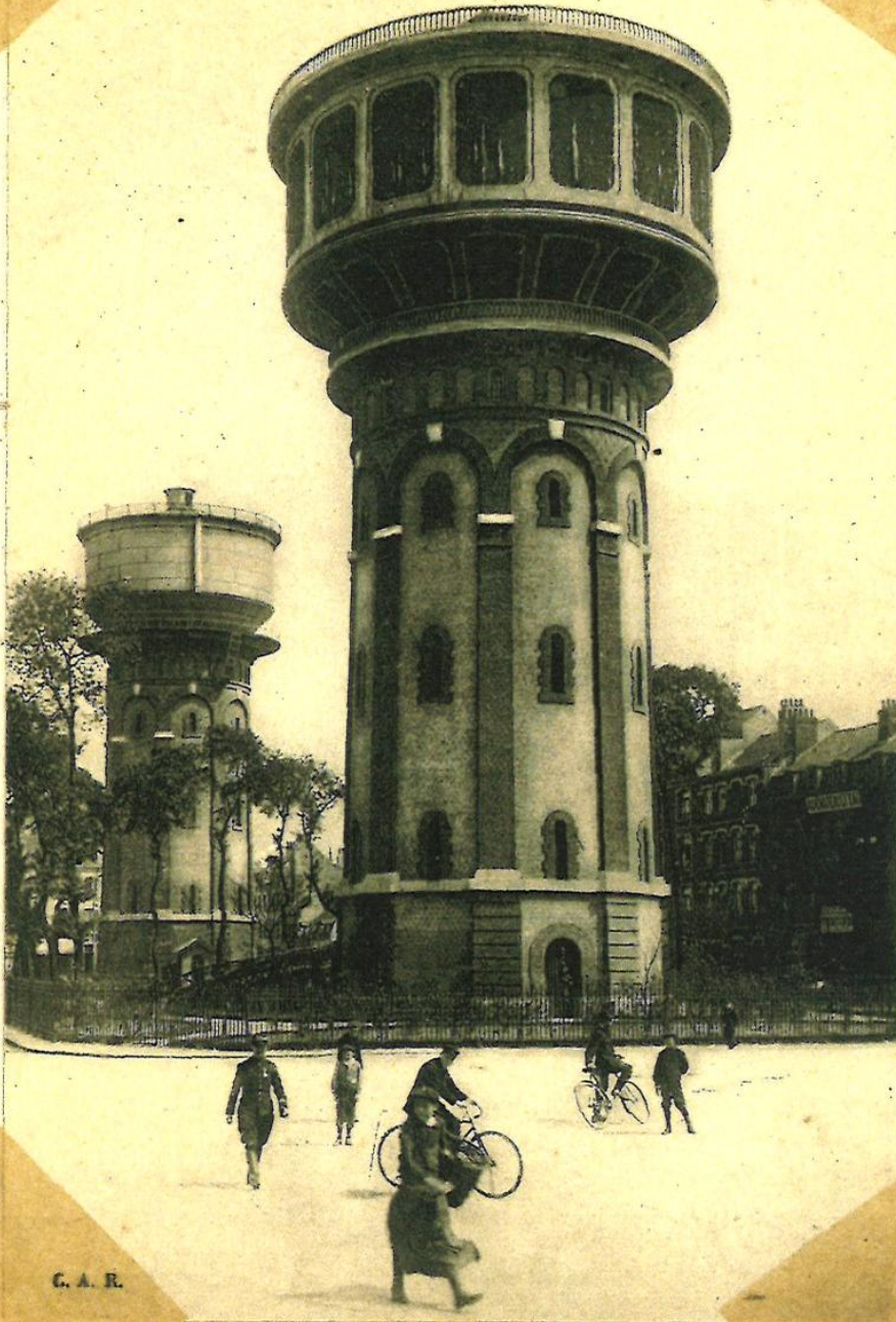
60. - DUNKERQUE. - Les Châteaux d'Eau
